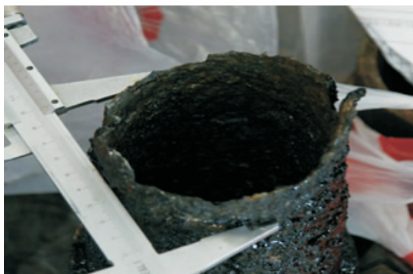
图1 塔河油田 T801(K)井第 471 根油管断裂
